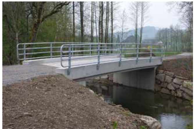
Brückenausbau in Ach
